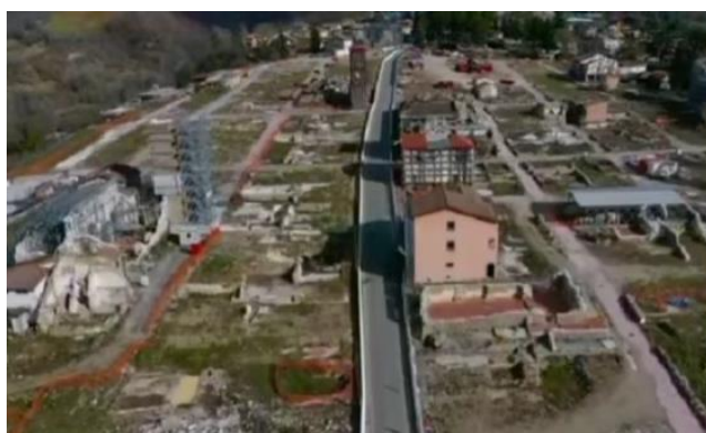
Veduta del centro storico post sisma
