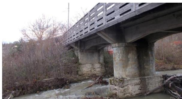
Tale intervento si rende necessario al fine di adeguare dal punto di vista idraulico la sezione del ponte. Infatti, la capacità di deflusso della sezione del ponte non è sufficiente a smaltire in sicurezza le portate di progetto in particolare quella con TR pari a 200 anni.
