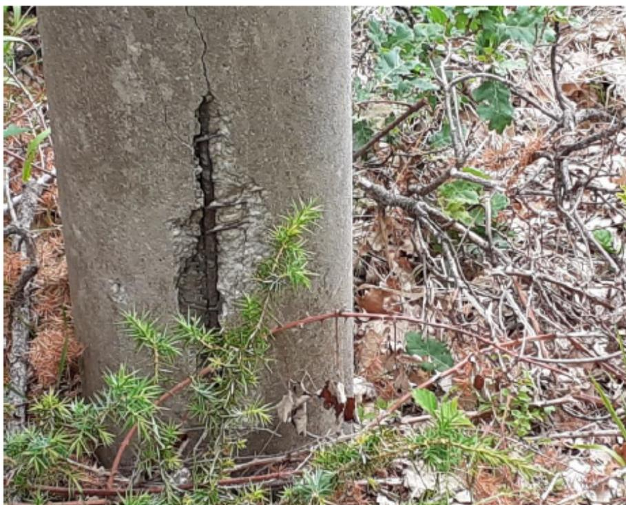
*Alcuni esempi di danni ai pali di cemento della Media Tensione*
